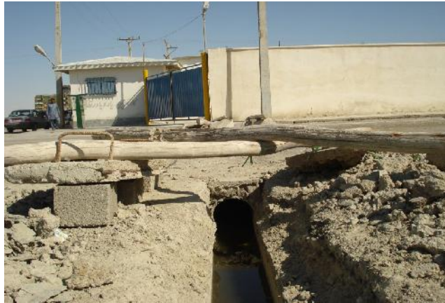
شکل ۲- کانال انتقال دهنده پساب خروجی از یکی از واحدهای شیلاتی در پسابندر
