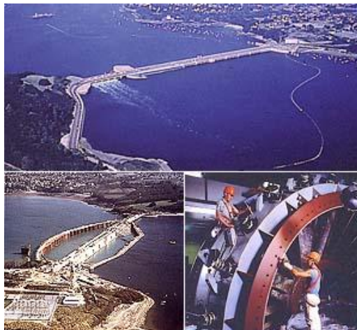
شکل ۳- نیروگاه جزر و مدی در فرانسه با ظرفیت MW۲۴۰ و تولید ۶۰۰ گیگاوات ساعت برق
