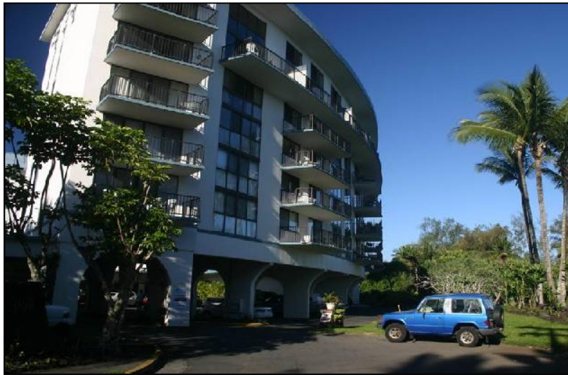
شکل ۷- ساختمان چند طبقه در منطقه آبرفتگی سونامی که طبقه همکف آن باز بوده و امواج سونامی میتوانند از آن عبور کنند.
