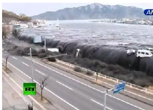
شکل ۴- عبور سونامی از روی دیوار سونامی در سال ۲۰۱۱ میلادی
